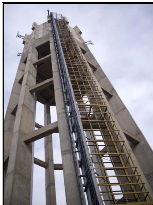
Figura 2. Vista de los pilares y escaleras del depósito
