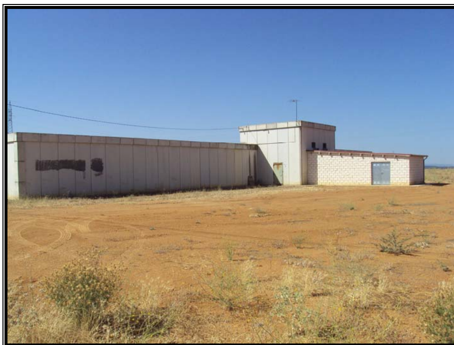
Figura 1. Vista general del depósito de la Coruña
