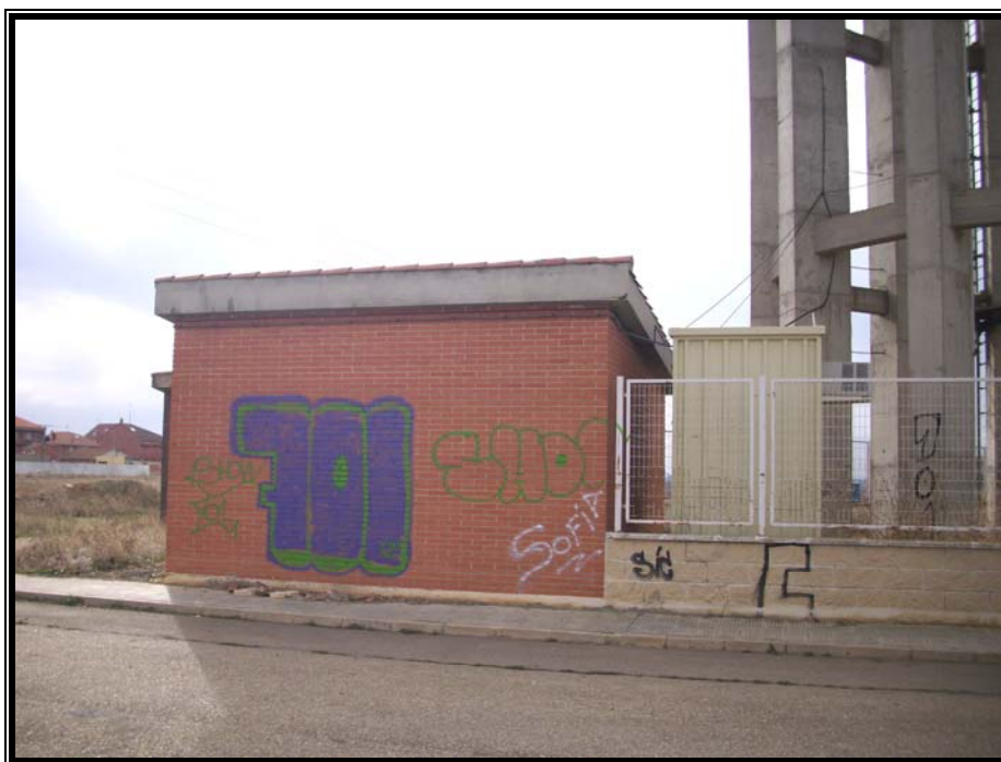
Figura 3. Caseta de sondeo del depósito
