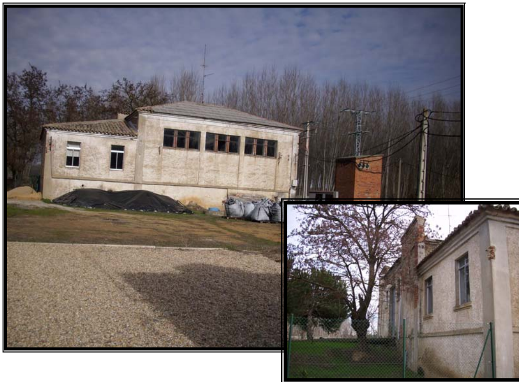
Figura 1. Fachada de la Casa de Aguas
