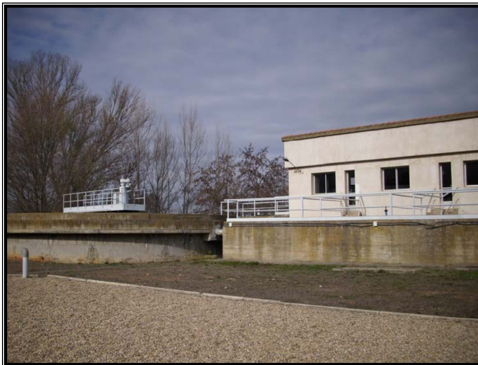
Figura 3. Vista exterior de la Estación de Tratamiento de Agua Potable
