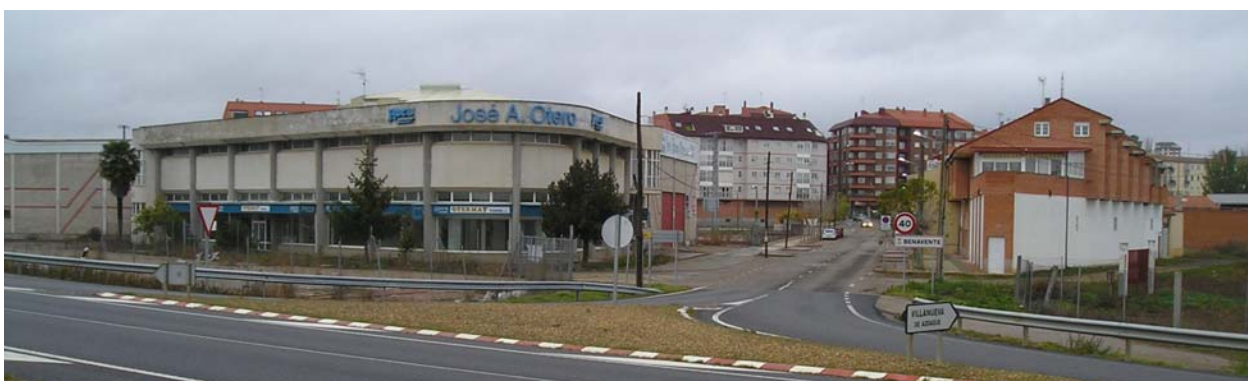
Confluencia de la N-525 a Orense con la Carretera de Villanueva de Azoague
