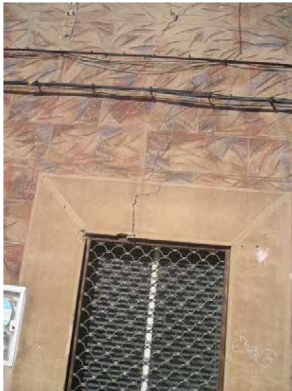
Figuración de revocos de fachada.
