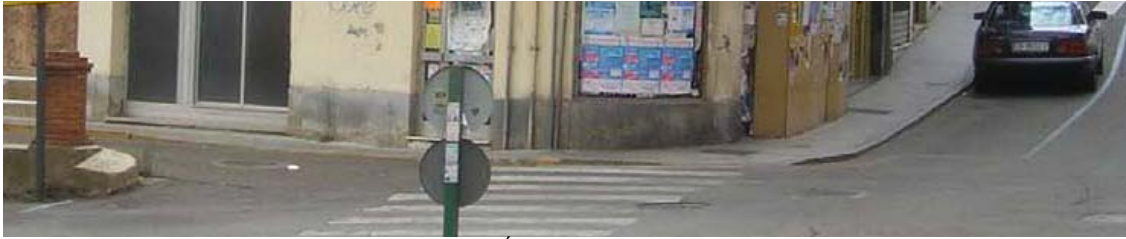
IMAGEN 1.- DETALLE DE HUMEDADES EN LOS ZÓCALOS.
