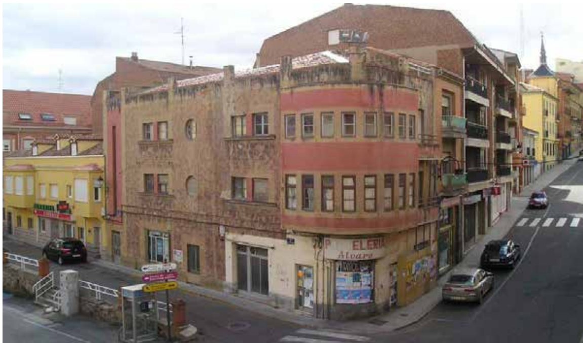
VISTA GENERAL DEL EDIFICIO
