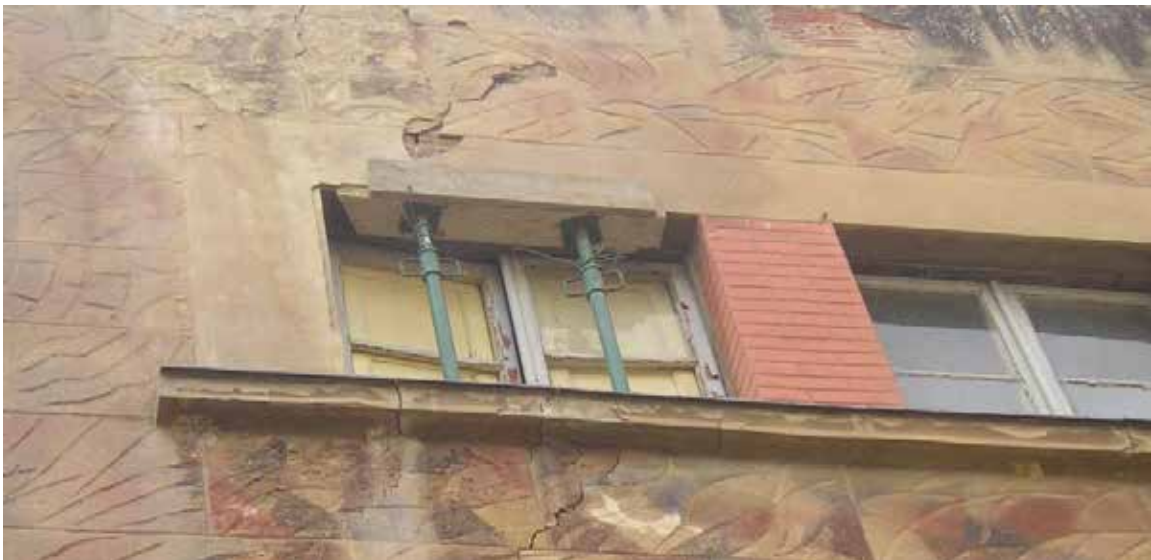
IMAGEN 11.- APUNTALAMIENTO DE VENTANA DE PLANTA 2ª EN PLAZA DE SAN FRANCISCO.
