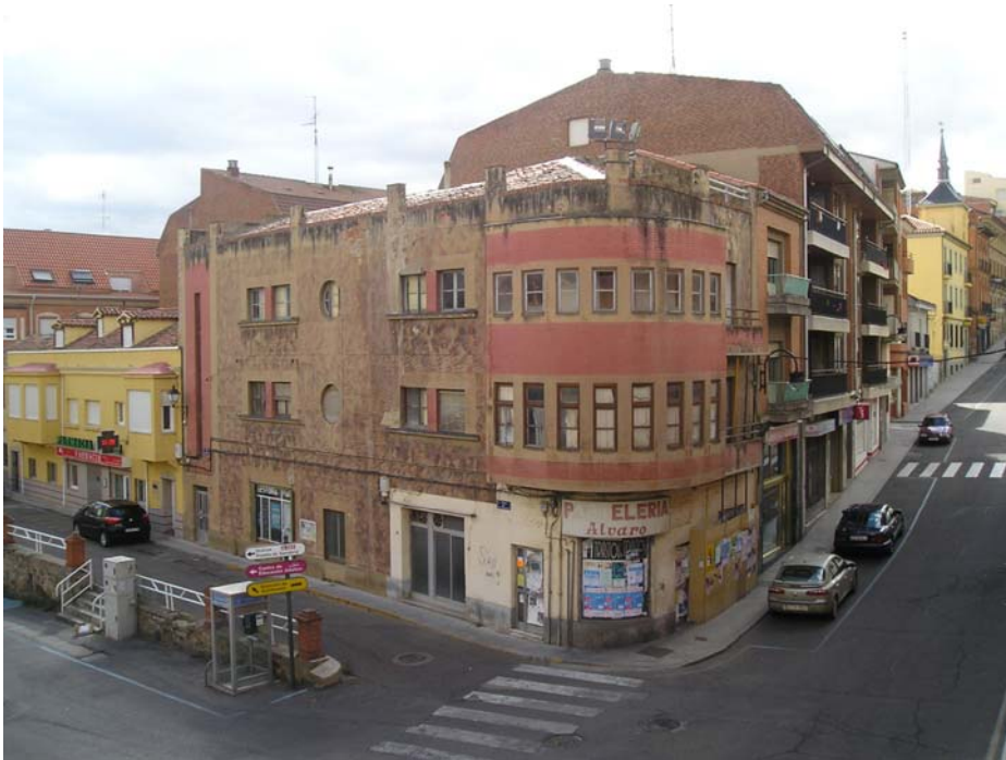
Imagen general del edificio.
